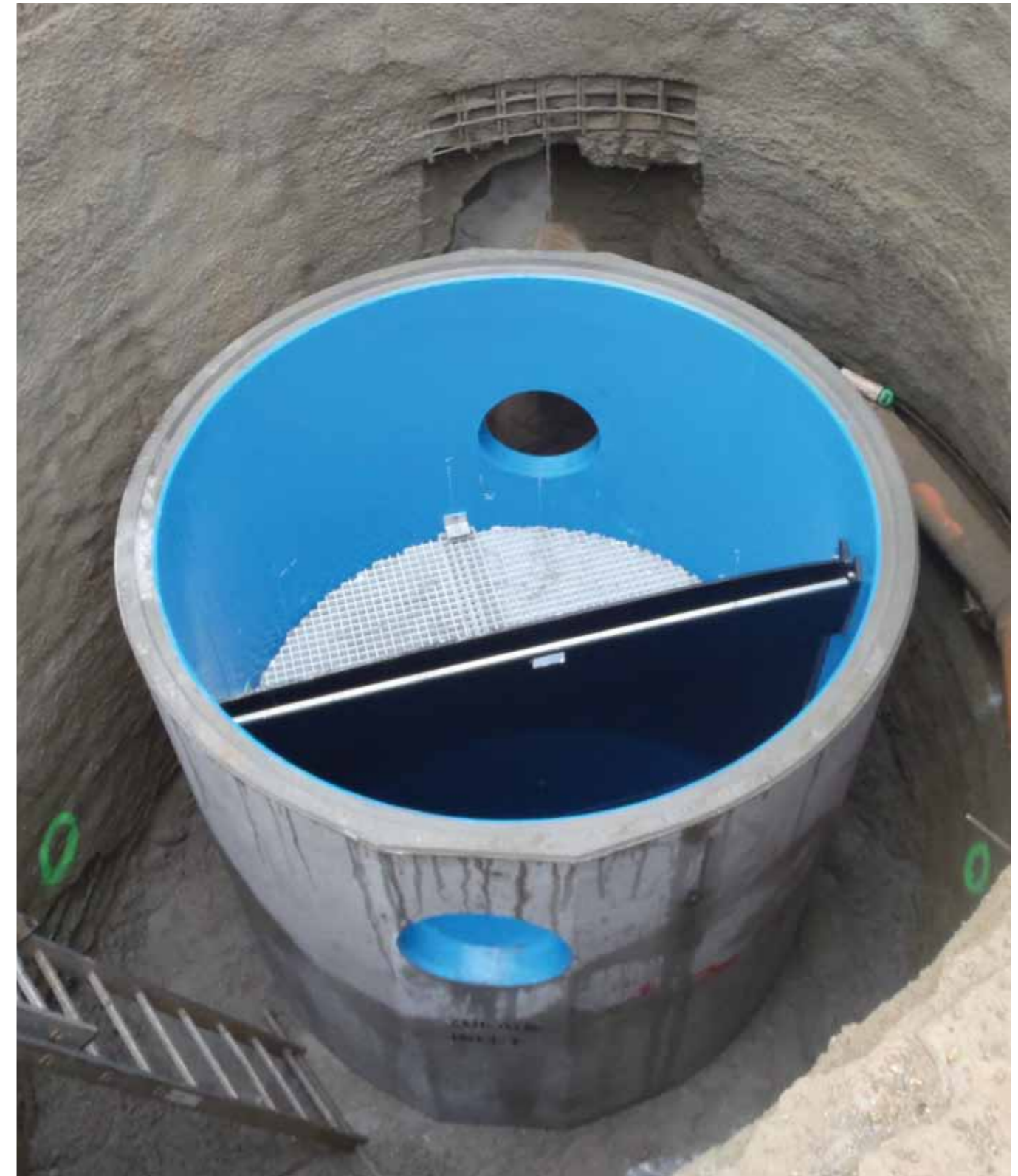
Einbau FiltaPex-Schacht in Wuppertal ©WSW Energie & Wasser AG
