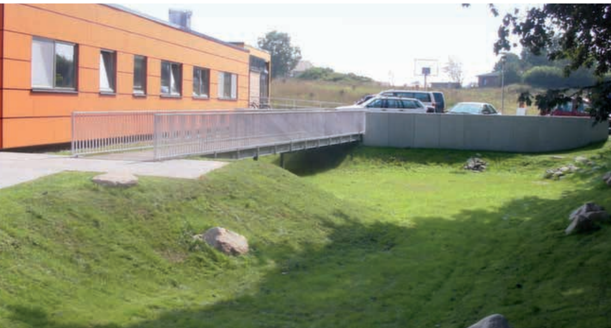
Muldenversickerung als Gestaltungselement, mit unterschiedlich geneigter Böschung
