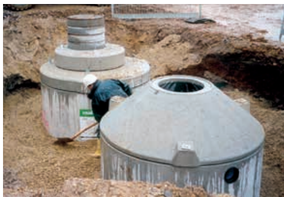
Einbau von Zisternen für die Regenwassernutzung
