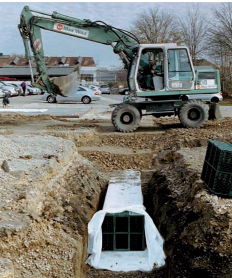
Füllkörper-Rigole im Bau (je nach Hersteller und System sind auch schwerlastbefähigte Bauweisen – SLW 60 – möglich)
