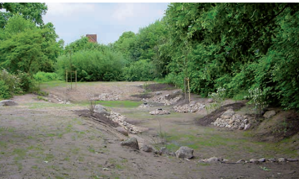
Mulden-Rigolen-Element kurz nach der Fertigstellung, vor Auflaufen der Rasensaat
