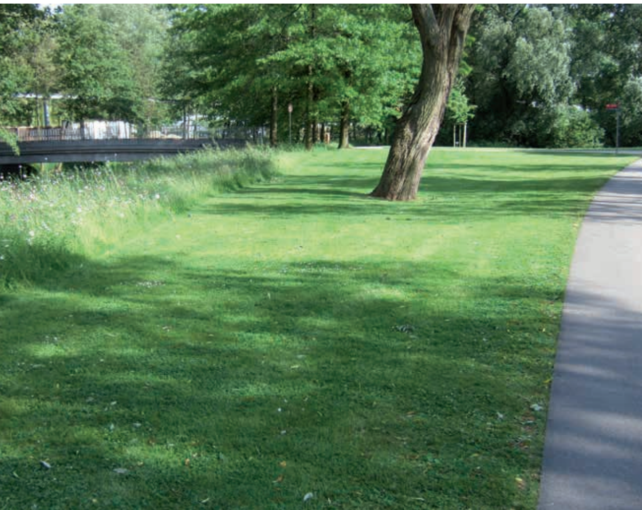
Flächenversickerung von Oberflächenwasser über ein Quergefälle im Weg
