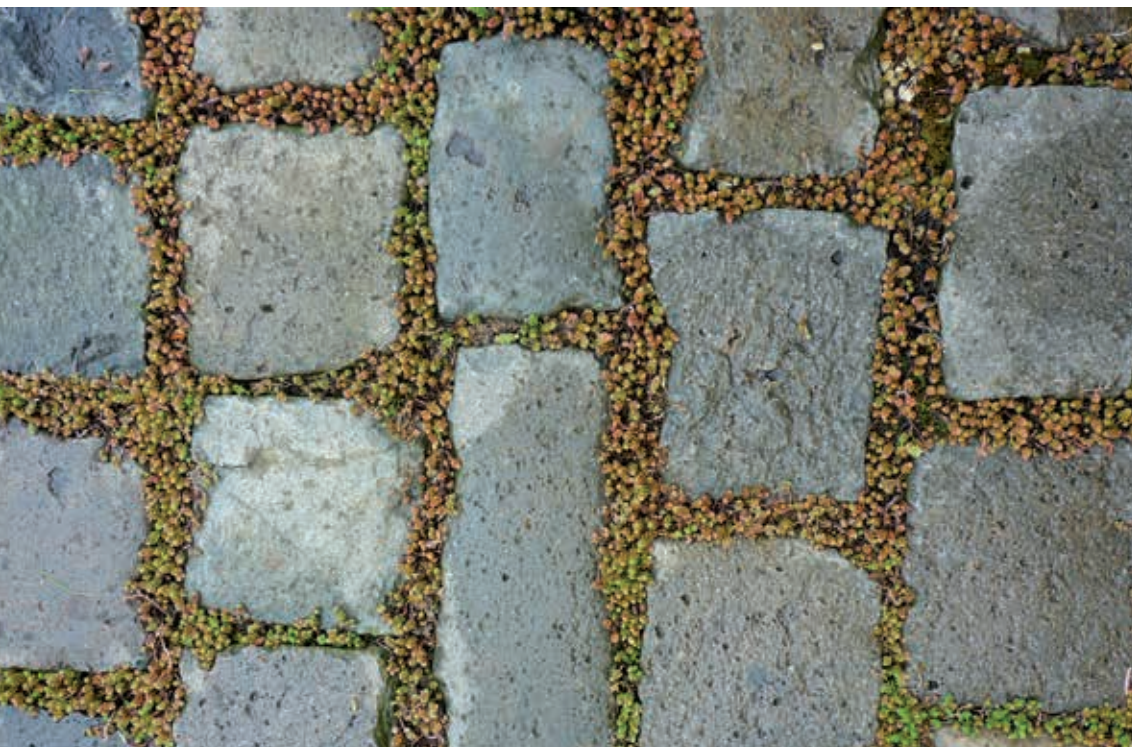
Auch Alt-Beläge lassen sich gut für eine wasserdurchlässige Wegefläche wiederverwenden. Bei geringer Nutzung können die Fugen auch attraktiv mit Mauerpfeffer bepflanzt werden
