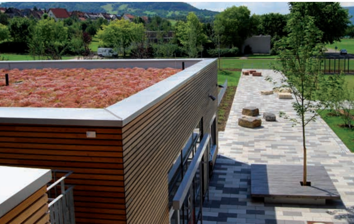
Dachbegrünungen bieten ganzjährig ein attraktives Bild für die höher gelegenen Klassenräume
