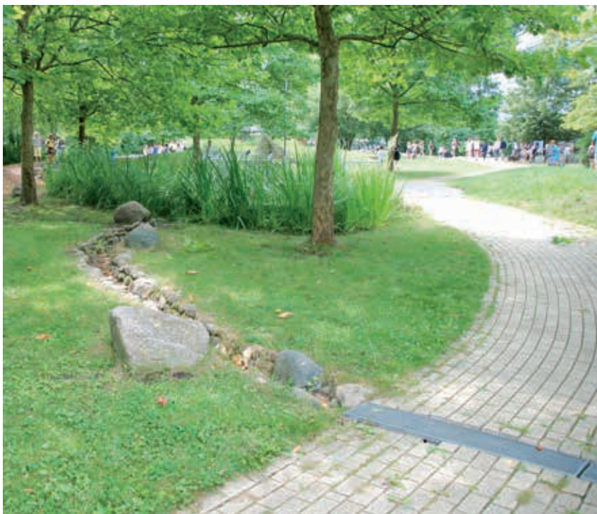
Mäandrierende Pflasterrinnen leiten das Wasser aus den Fallrohren über die Freiflächen der Schule in ein flaches Wasserbecken. Im Bereich von Wegen wird das Wasser in abgedeckten Kastenrinnen geführt
