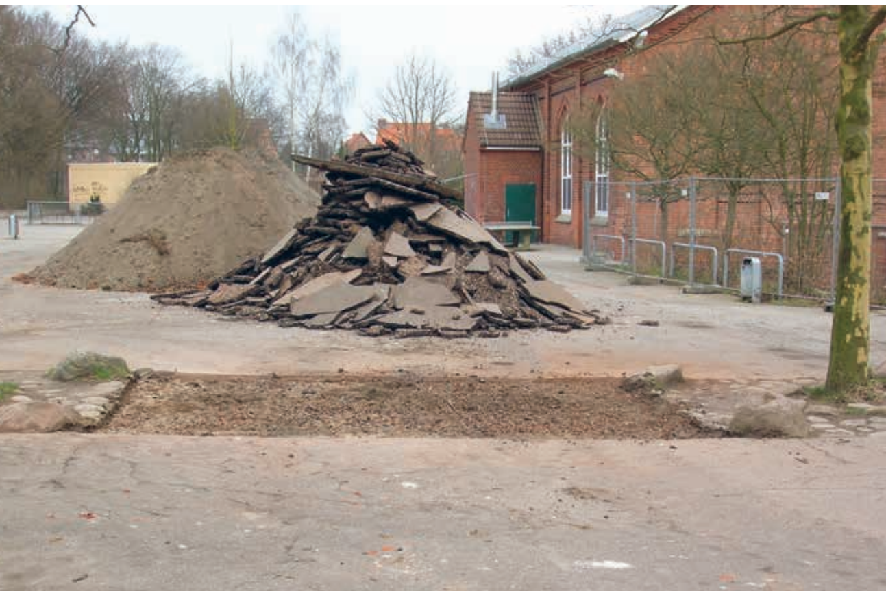
Wasserundurchlässige Asphaltflächen an der Schule Leuscherstraße werden entsiegelt
