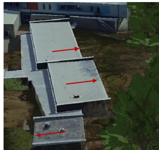
Abbildung 3 Dachfläche in 3D Ansicht (Blick nach Osten)
