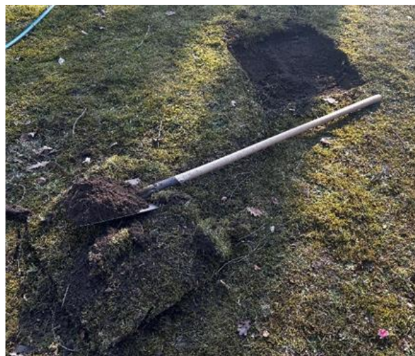
Abbildung 12 Aushub Probeschurf für einfachen Sickerversuch und Probenahme
