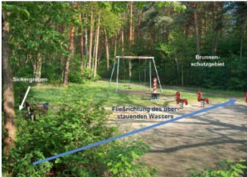
Bild 4. Überlaufsituation vom Sickergraben über einen angrenzenden Spielplatz.
