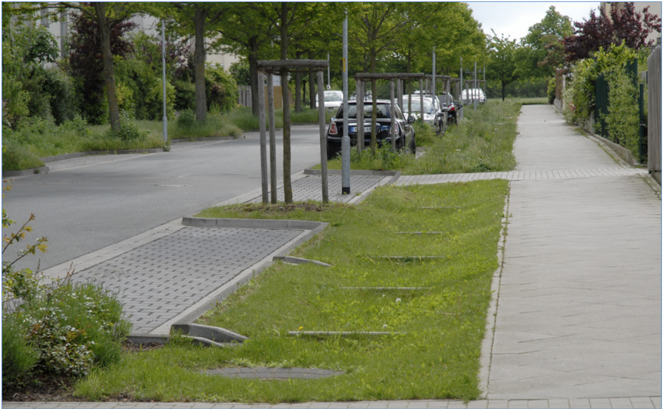
Abb. 20: Straßenbegleitende Muldenkaskaden
