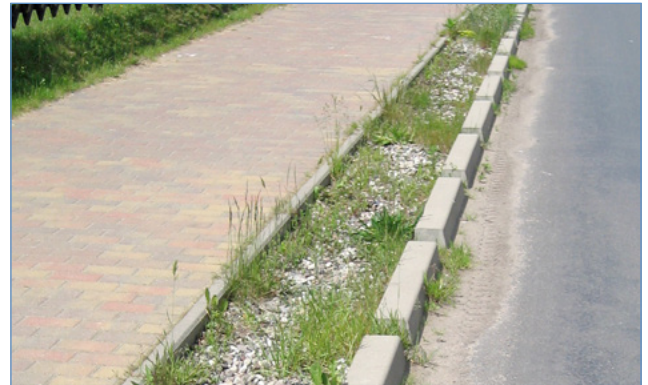
Abb. 7: Straßenbegleitender Versickerungstreifen
