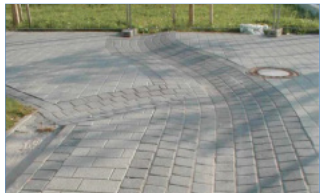
Abb. 9: Gepflasterte Muldenrinne zur Ableitung in eine Grünfläche
