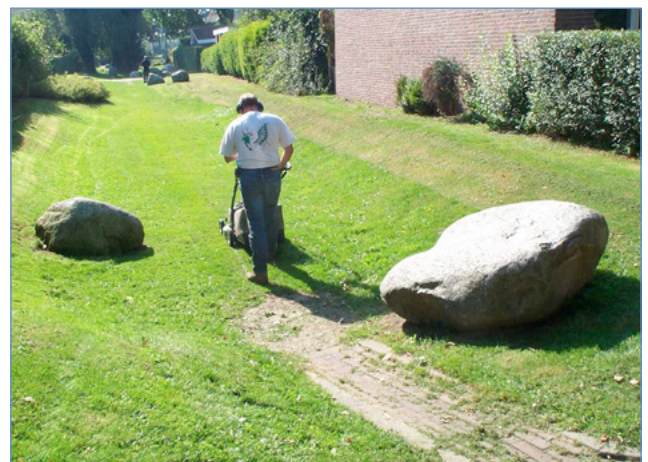
Abb. 76: Mahd einer Versickerungsmulde
