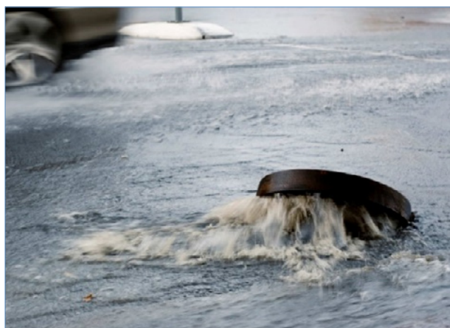
Abb. 4: Sielüberstau als Folge eines Starkregenereignisses
