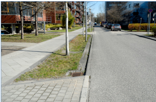
Abb. 24: Versickerung der Gehwegabflüsse in Rigolen
