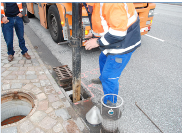
Abb. 73: Reinigung einer Trumme
