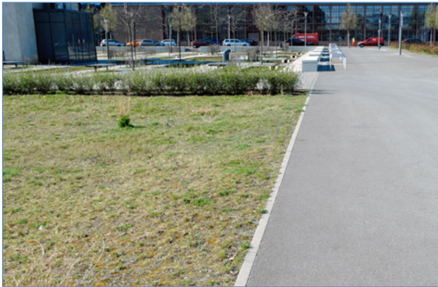
Abb. 22: Flächenversickerung durch den bewachsenen Boden
