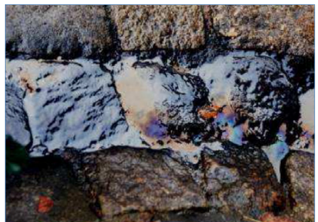
Abb. 3: Schadstofffahne im Straßenabfluss
