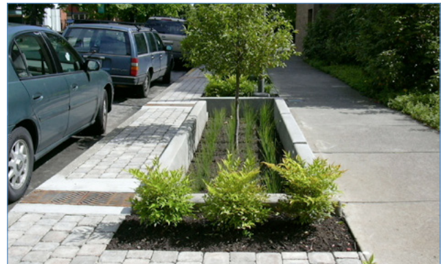
Abb. 8: Tiefbeet im Gehwegbereich
