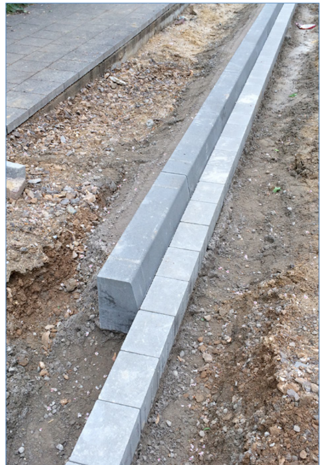
Abb. 36: Grundinstandsetzung einer Straße
