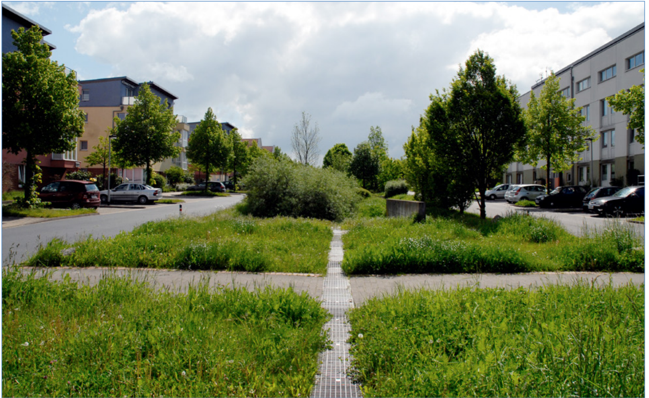
Abb. 30: Großflächige Versickerungsmulden im Mittelstreifen
