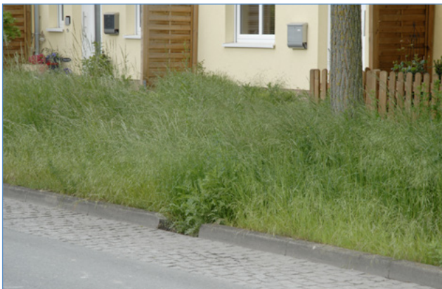
Abb. 25: Straßenentwässerung in bepflanzte Versickerungsmulde
