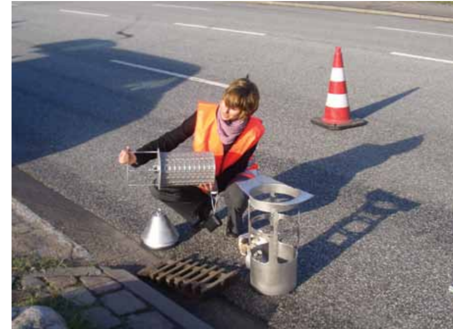
Testbetrieb einer dezentralen Behandlungsmaßnahme in Hamburg © HAMBURG WASSER
