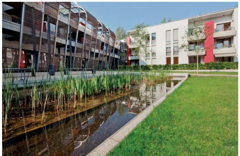
Regenwasserbecken im Neubaubereich des Quartiers „Johanniskirchgärten“ in Essen-Altenessen (Vivawest Wohnen, Fotograf: Adrian Bedoy)
