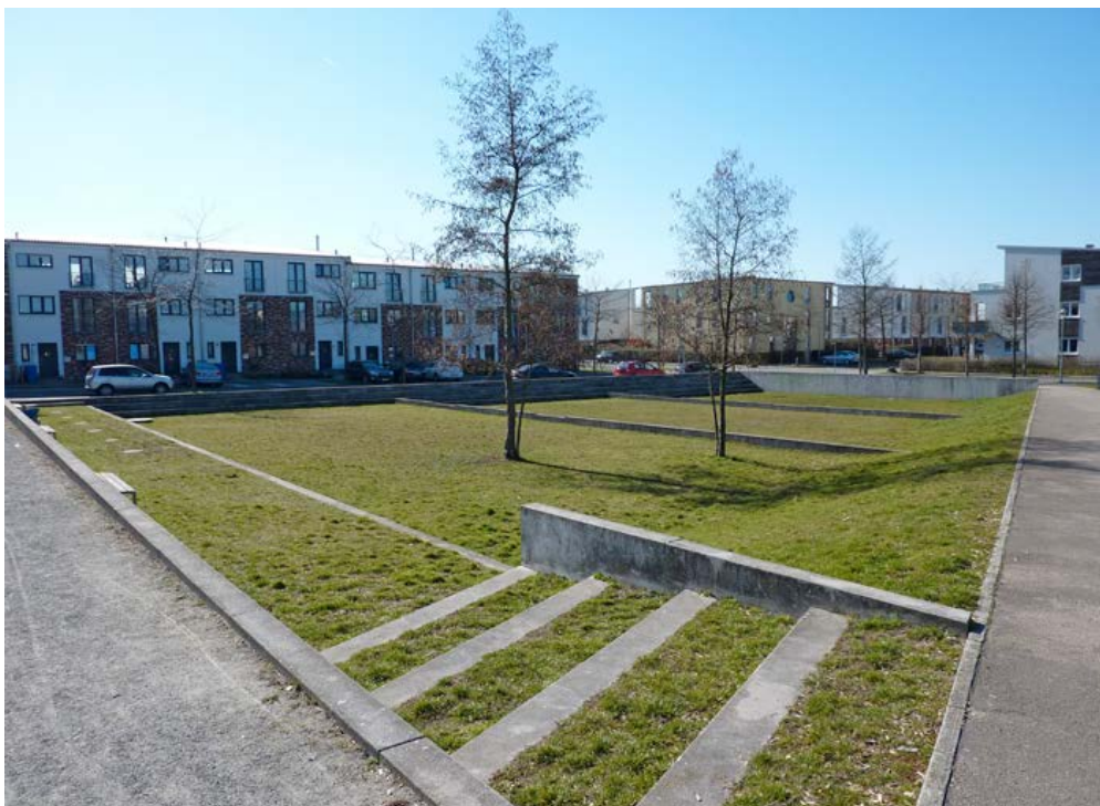
Die Gestaltung der Grünfläche in der Südlichen Gartenstadt Potsdam ermöglicht den gefahrlosen kurzzeitigen Einstau von Regenwasser bei seltenen Starkregenereignissen (Foto: Entwicklungsträger Bornstedter Feld)
