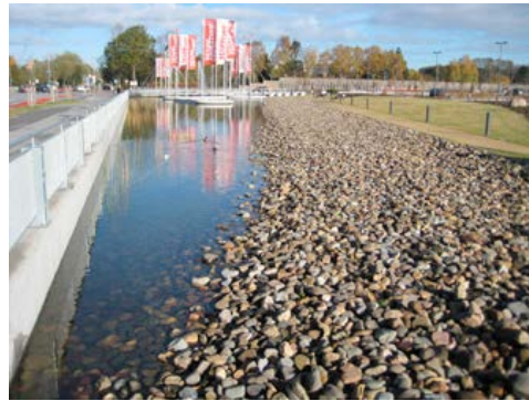
Wasserrückhaltung im Gewerbegebiet MÖBEL HÖFFNER, Hamburg-Eidelstedt (Foto: BSU)
