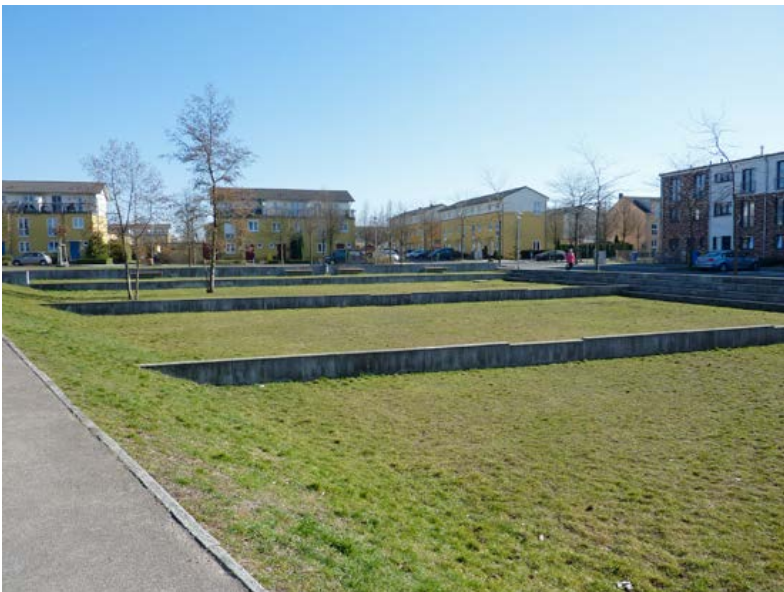
Versickerungsfläche im Quartierspark Südliche Gartenstadt (Foto: Entwicklungsträger Bornstedter Feld)
