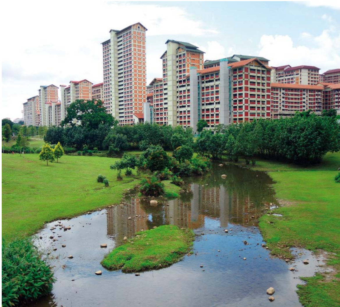
Abb. 2.38: Das aufgeweitete Gewässerprofil des Kallang Rivers im Bereich des Bishan Ang Mo Kio Parks mit Zulauf aus den angrenzenden Wohngebieten und umgebenden Straßen sowie das betonierte Verbindungstück zum Reservoir (nächste Seite, rechts oben). Die Bevölkerung interagiert mit dem Fluss bzw. nutzt den neugestalteten Park für Freizeitaktivitäten.
