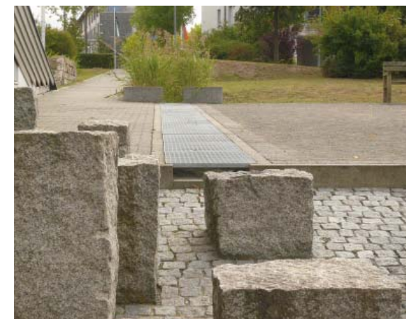
Abb. 3.68: Je nach Alter der Kinder können die überfluteten Bereiche auch sehr flach ausgebildet sein, um den Sicherheitsanforderungen gerecht zu werden. (Beispiel: Kronsberg in Hannover)
