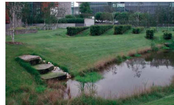
Abb. 3.52: Alternativ könnten „blau-grüne Elemente“ in die Grünflächen integriert werden und neben dem Wasserrückhalt der Verbesserung des Mikroklimas dienen (Foto oben: Augustenborg in Malmö; Foto unten: FinanzIT in Hannover).
