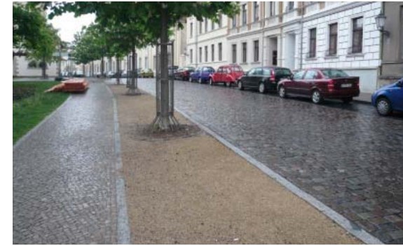
Abb. 3.57: So könnte die Gestaltung einer versickerungsfähigen Pflanzgrube aussehen. Der Wasserzulauf würde unterirdisch durch einen Luftbrunnen erfolgen, der einem normalen Straßenablauf ähnelt. Er führt das Wasser in die Pflanzgrube und ist wie ein Straßenablauf in der Pflasterrinne der Straße angeordnet.
