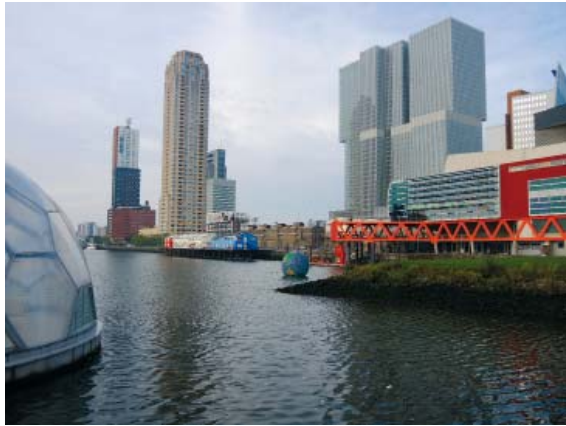
Abb. 2.19: Moderne Bauprojekte auf Kop van Zuid
