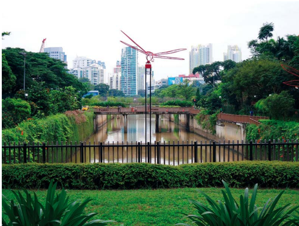
Abb. 2.34: Blick auf eines der Demonstrationsprojekte am Alexandra Kanal im zentralen Einzugsgebiet. Das Niederschlagswasser wird in diesem hochverdichteten Gebiet aus Platzgründen auf einem „grünen Deckel“ über dem Kanal zurückgehalten. Ein System aus Reinigungsbiotopen sorgt für eine verbesserte Wasserqualität, bevor das Wasser in den Kanal gelangt.
