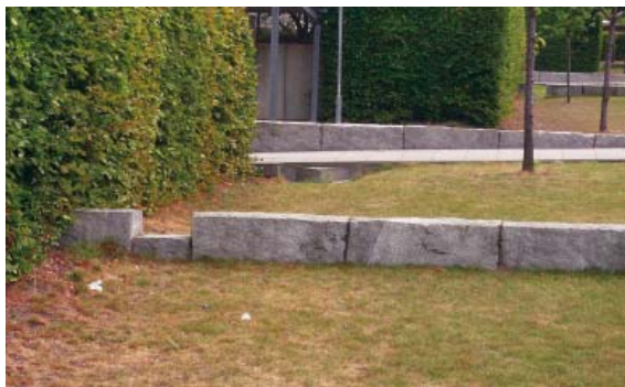
Abb. 3.50: Im späteren Entwurf könnten Höhengsprünge innerhalb der Grünfläche gestalterisch akzentuiert werden und dem Rückhalt und der Versickerung des Wassers dienen, wie in Augustenborg in Malmö oder am Kronsberg in Hannover.
