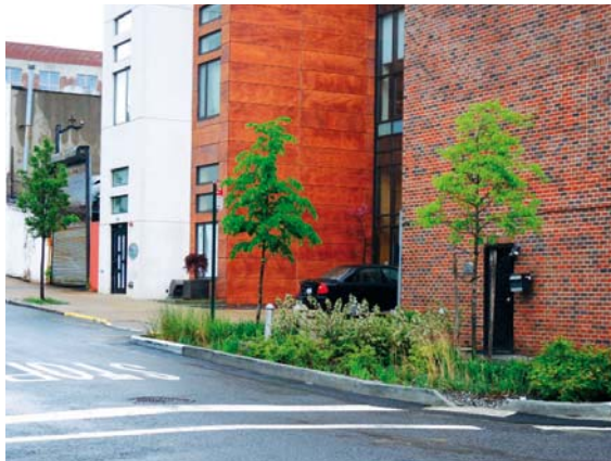
Abb. 2.16: Eine bereits umgesetzte Greenstreet im Einzugsgebiet des Gowanus Canals mit Zulauf (Mitte) und Überlauf auf die Straßen (rechts)
