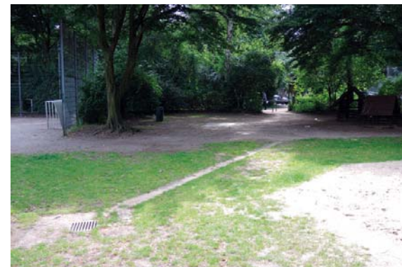
Abb. 3.64: Der Spielplatz ist recht großzügig bemessen und hat heute bereits einen Straßenablauf an seinem Tiefpunkt.
