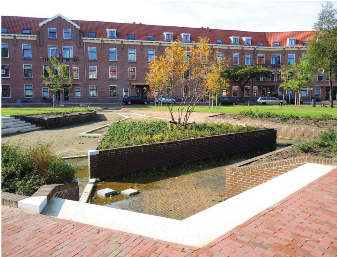
Abb. 3.67: Fallen größere Mengen an Niederschlagswasser an, kann bspw. ein Sitzbereich für Kinder, Jugendliche und Eltern temporär geflutet werden und das Wasser der umliegenden Wohnstraßen temporär speichern, wie am Bellamyplein in Rotterdam. Offene Rinnen leiten das Wasser zum Platz (Foto rechts oben).
