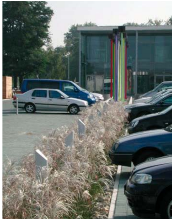
Abb. 3.59: Beispiele für mit Gräsern bepflanzte Versickerungsbeete: Die Zuleitung des Regenabflusses kann entweder flächendeckend oberirdisch erfolgen wie bei der VW Bank in Braunschweig (siehe linkes Foto) oder gezielt durch eine Rinne wie am Kronsberg in Hannover (siehe rechtes oberes Foto). Die erhöhte Betonkante kann sowohl aus gestalterischen als auch aus Gründen der Verkehrssicherheit eingesetzt werden.
