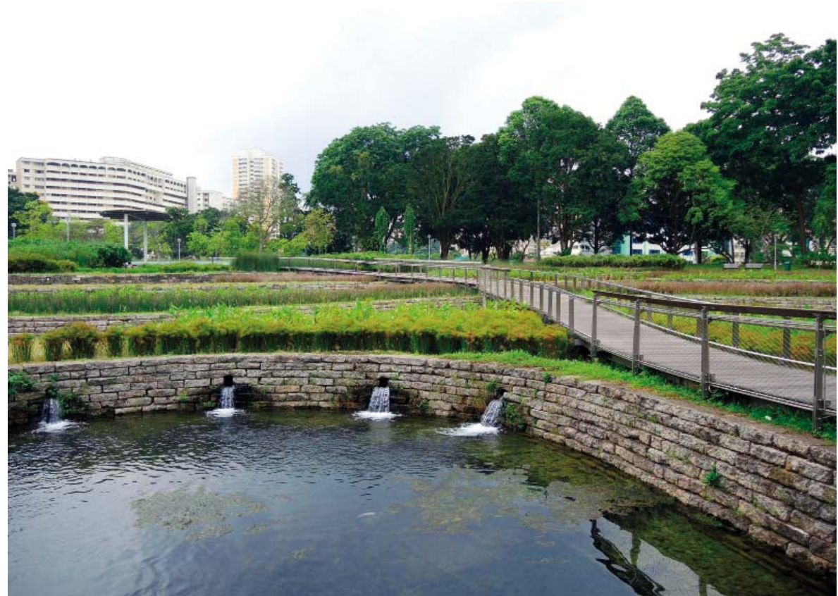
Abb. 2.40: Blick auf das Reinigungsbiotop, das den Regenabfluss der angrenzenden Quartiere und Straßen reinigt.
