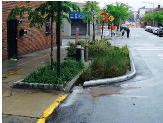
Abb. 2.16: Eine bereits umgesetzte Greenstreet im Einzugsgebiet des Gowanus Canals mit Zulauf (Mitte) und Überlauf auf die Straßen (rechts)
