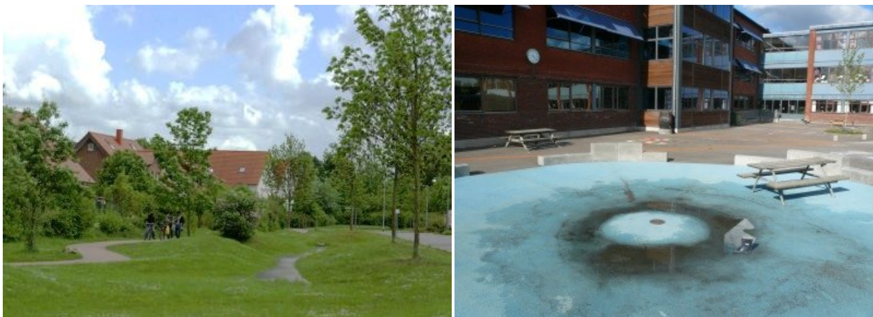
Abbildung 5.30: Links: zentraler Grünzug mit Versickerungsmulden Langenhagen Weiherfeld (Bild: Andresen, S., HCU), Rechts: Regensammelfläche mit verzögertem Abfluss Kopenhagen, Brondbyvesterskole (Bild: Kruse, E., HCU)
