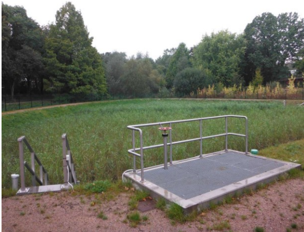
Abbildung 1.5: Retentionsbodenfilteranlage Plettenberg (Bornmühlenbach), Hamburg, Bezirk Bergedorf. RISA-Pilotprojekt (Grundlagenermittlung, Behandlungskonzept, Vorplanung und Monitoring), Quelle: Waldhoff
