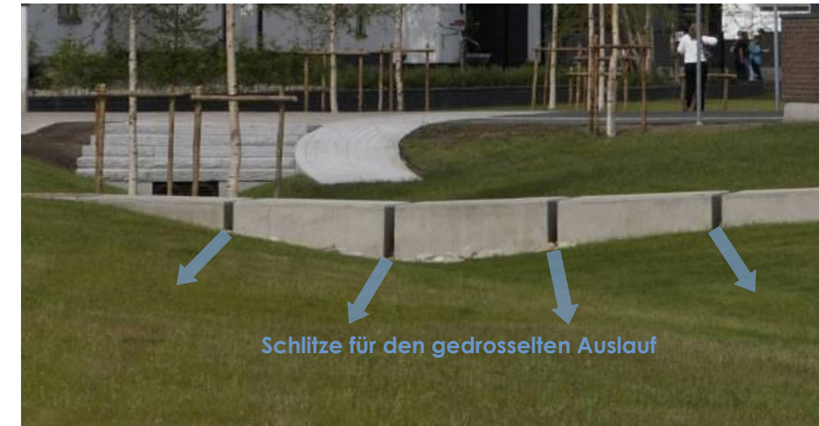
C- Trittsteine in Kombination als Abflussdrossel
