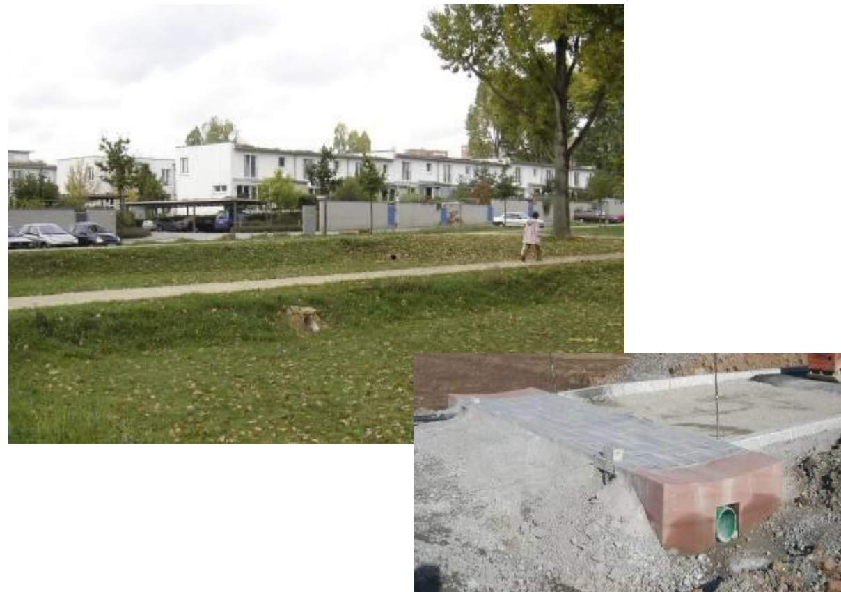
B- Damm mit Rohr- oder Rinnendurchlass
